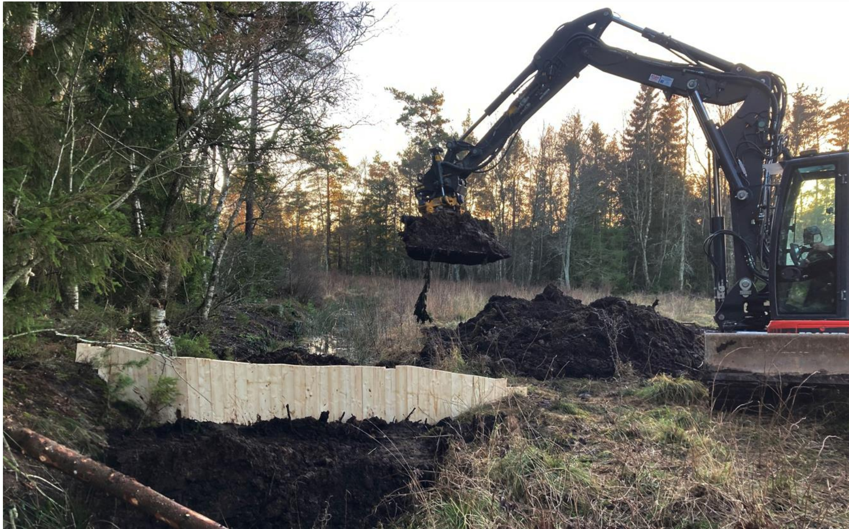
Enkelpalissad av spåntad plank. Täcks över helt med torv
